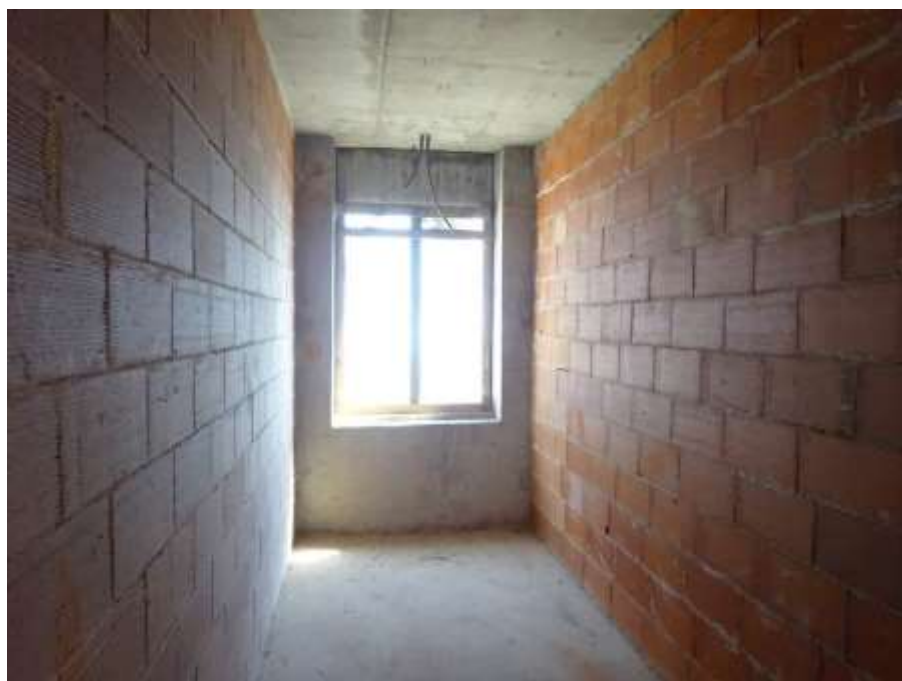
Autre pièce en suivant (Réserve) avec une fenêtre en façade Sud.
